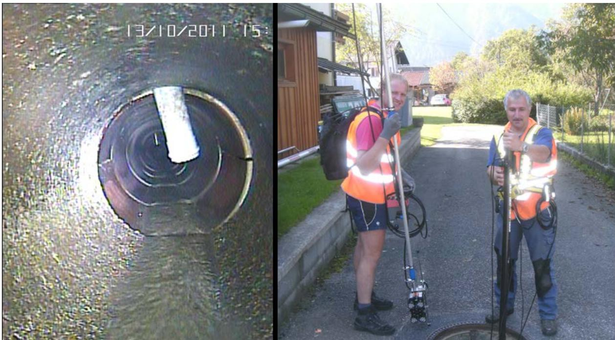
Abbildung 28 – Inspektionen mittels elektronischem Spiegel (INNOKANIS, 2011)
