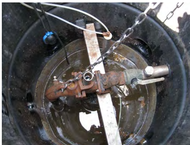
Abbildung 8-4: Pumpstation für Einzelobjekte
