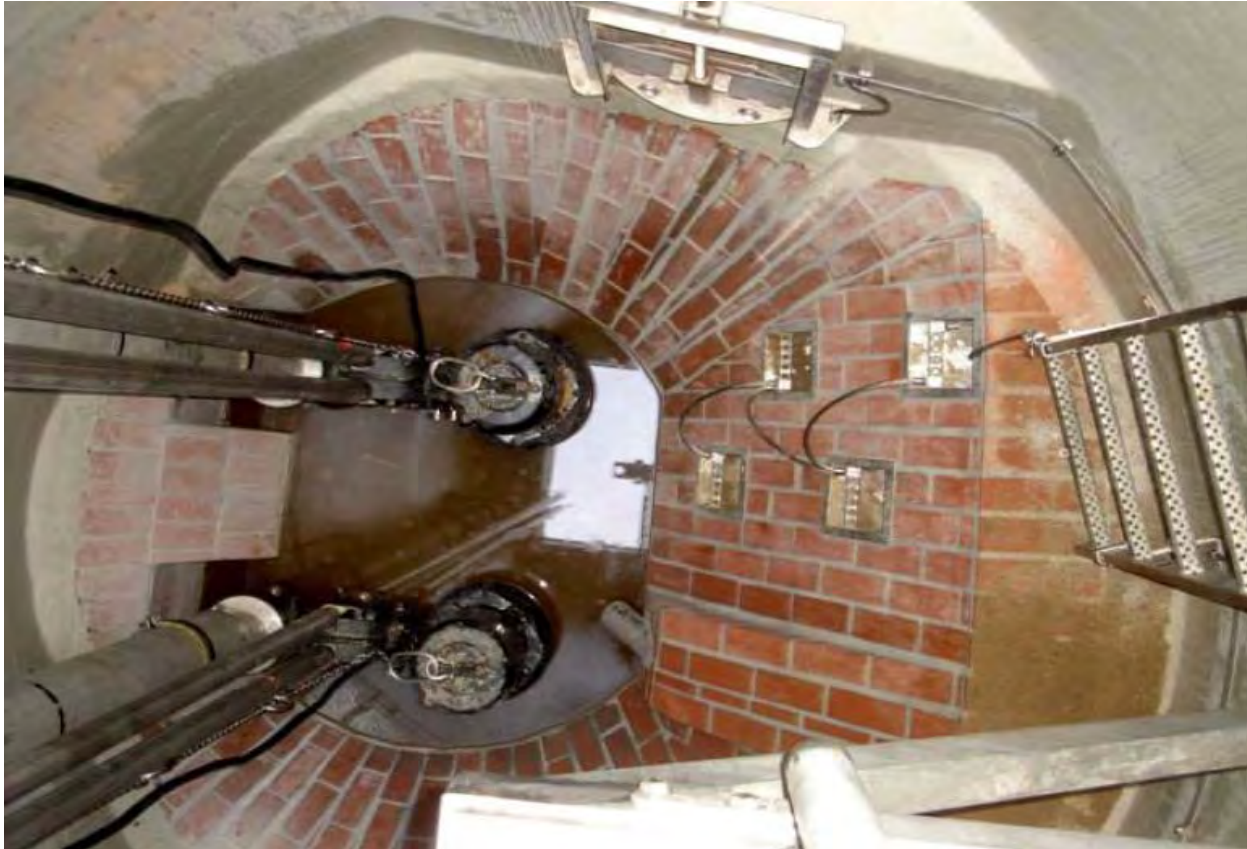
Abbildung 9-12 – Pumpensumpf nach Adaptierung (TORNOW, 2010)
