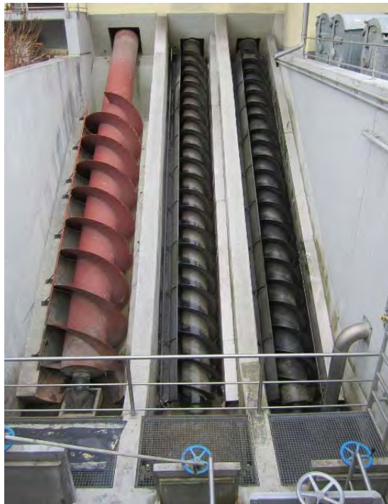
Abbildung 3-19: Schneckenpumpe (Photo: Schitter)
