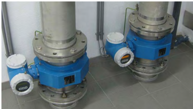
Abbildung 4-33: Magnetisch-Induktive Durchflussmessung (Schitter)
