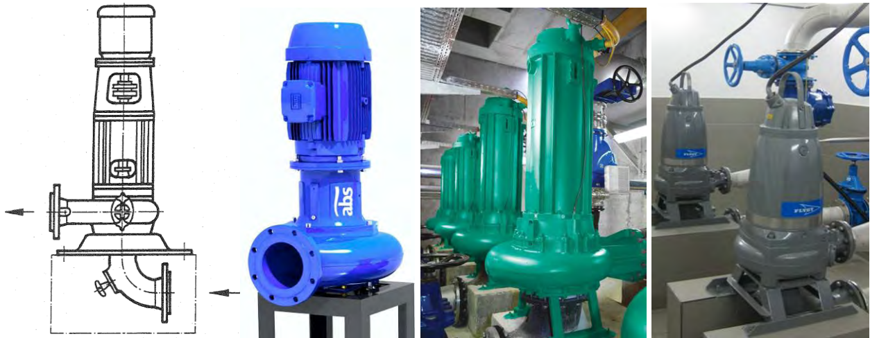
Abbildung 4-31: Trocken und vertikal aufgestellte Kreiselpumpe (ATV-DVWK-A 134, 2000; ABS, 2011; WILO, 2008; Schitter)
